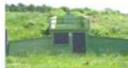
Réservoir de Fleury la Vallée 600 m 3
